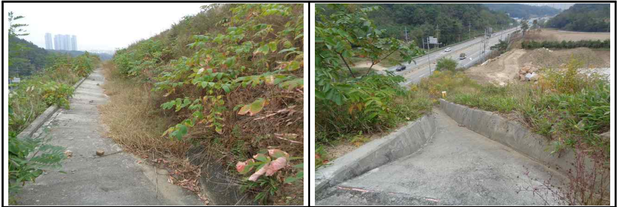
【그림 10.3.3】 배수시설 전경
